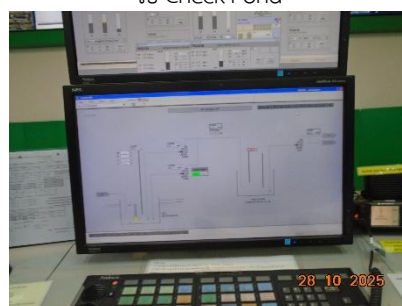
ภาพที่ 2-27 การควบคุมระบบบำบัดน้ำเสียด้วย DCS
