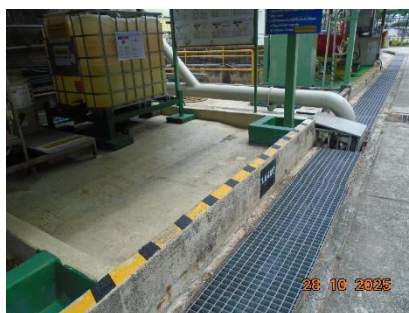
ภาพที่ 2-58 Bund Wall บริเวณที่เก็บสารเคมี
