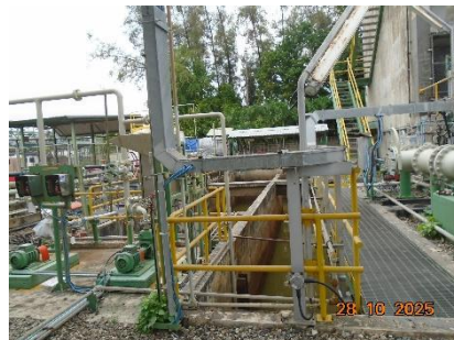
ภาพที่ 2-17 API Separator
