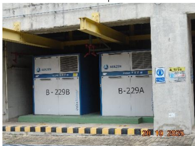
ภาพที่ 2-28 Acoustic Enclosure บริเวณ B-229 A/B
