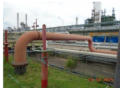
ภาพที่ 2-51 ท่อรับน้ำดับเพลิงจาก PTT GC
