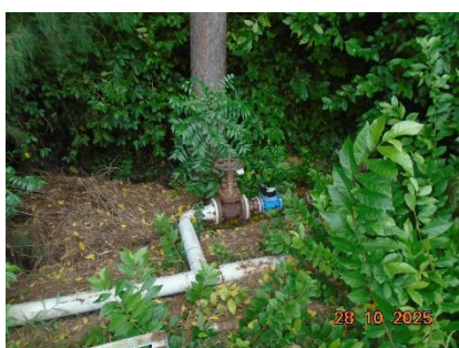
ภาพที่ 2-20 ท่อน้ำเสียที่ส่งไปบำบัดที่ PTT GC
