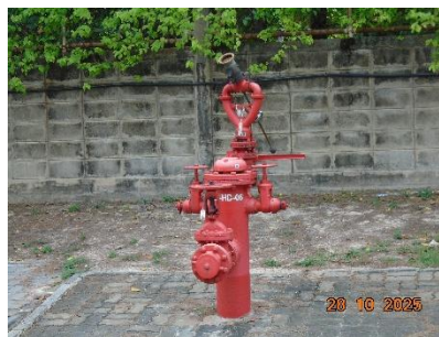
ภาพที่ 2-35 Three-Way Valve (Fixed Monitor)
