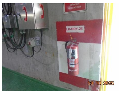
ภาพที่ 2-43 ถังดับเพลิงมือถือชนิดผงเคมีแห้ง
