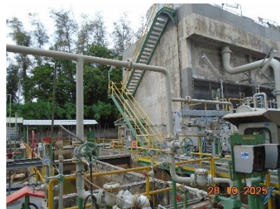
ภาพที่ 2-25 ท่อส่งน้ำจาก API Separator ไป Check Pond
