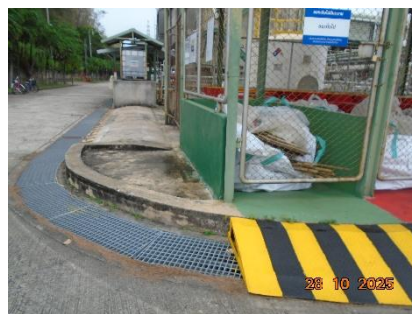
ภาพที่ 2-11 บริเวณที่รวบรวม Low Polymer ที่มีคั่นคอนกรีตล้อมรอบ
