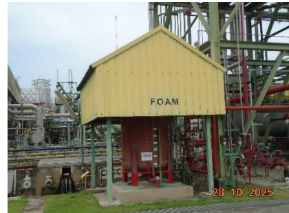
ภาพที่ 2-49 Foam Bladder Tank
