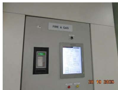
ภาพที่ 2-37 Fire Alarm และแผงควบคุมระบบ Fire Alarm
