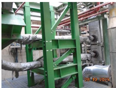
ภาพที่ 2-34 Rupture Disc PSF บริเวณ Vent Stack
