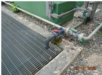
ภาพที่ 2-24 ท่อส่งน้ำทิ้งจาก Cooling Tower Blowdown ไป API Separator
