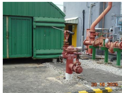
ภาพที่ 2-39 ระบบหัวฉีดดับเพลิงแบบ 2 ทาง
