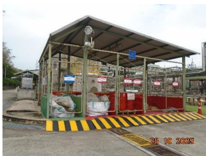
ภาพที่ 2-10 พื้นที่รวบรวมน้ำมันและไขมันจาก API Separator
