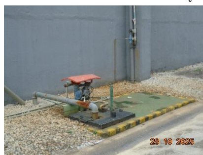
ภาพที่ 2-21 บ่อบักน้ำเสียจากหน่วย Initiator และ Catalyst
