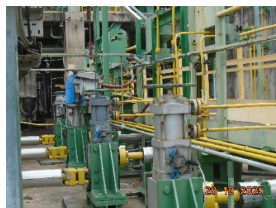
ภาพที่ 2-33 Interlock Valve บริเวณถังปฏิกรณ์
